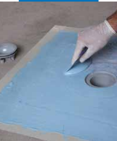
Ammorsamento del tessuto di Drain Vertical con Mapelastic AquaDefense
